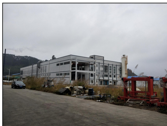
园区污水处理厂
