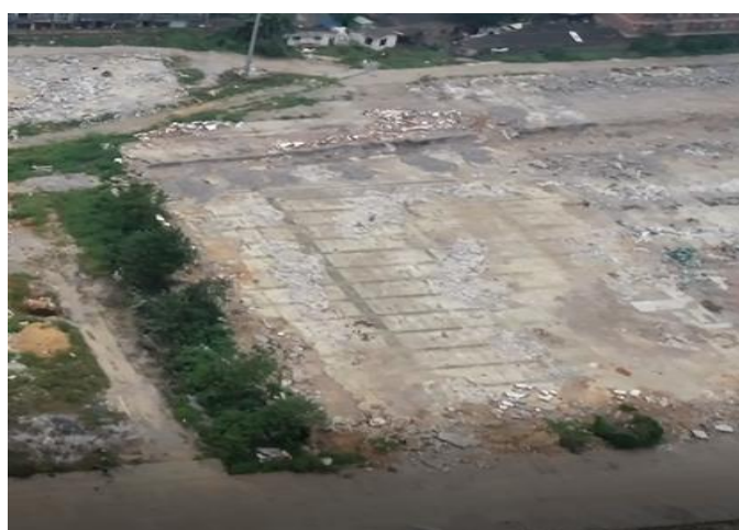
地块二西部已拆除的仓库区（2020.10.13）
