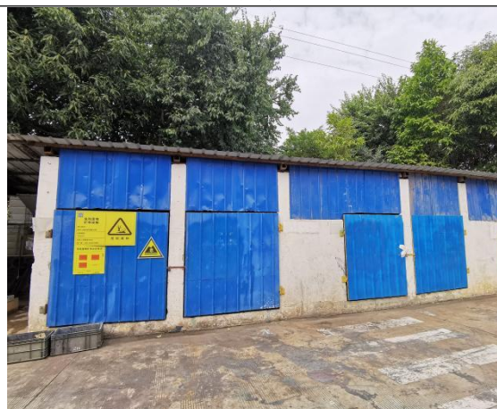
企业危险废物暂存间现状照片
