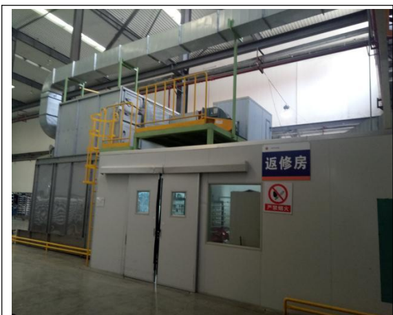
项目涂装生产线返修房
