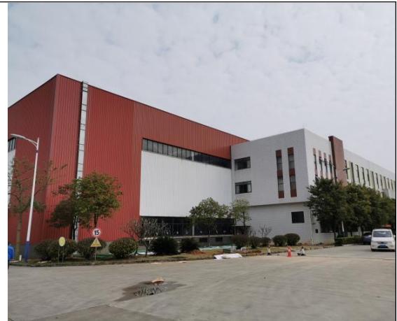
企业车用换热器及暖风机生产基地
