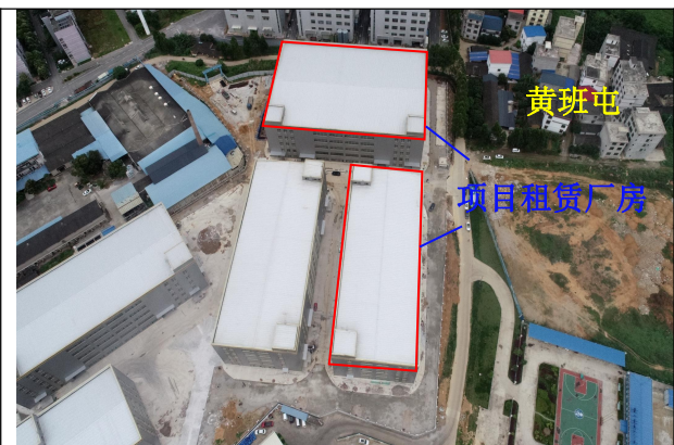
项目场地俯视照片
