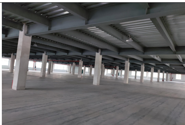
项目租赁厂房内部现状照片
