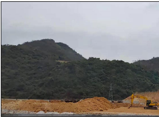
项目南面山体
