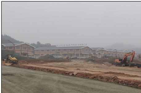
项目东北面150m处标准厂房现状
