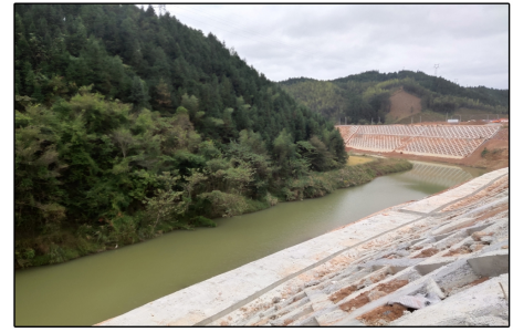
污水处理厂西面洒里河及护坡
