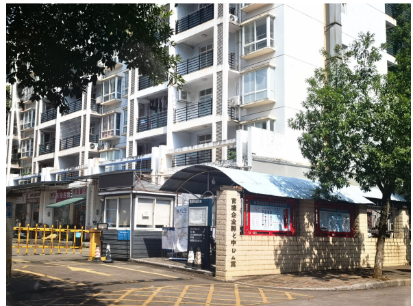
项目西北面官塘企业孵化中心公寓
