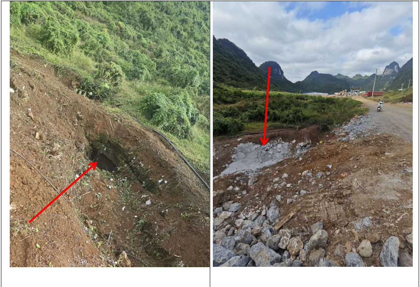
图3.1-2 消水洞封堵前后照片
