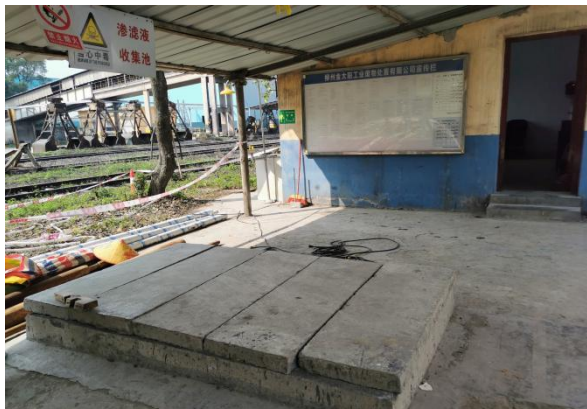
现有危险废物贮存库废液池
