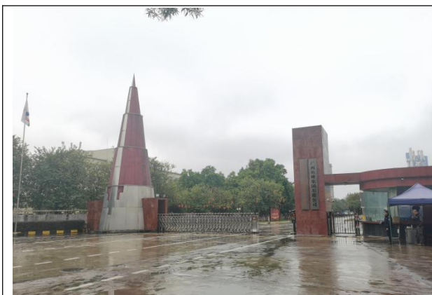
项目所在鱼峰水泥公司厂区东门
