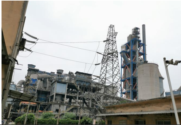
2500t/d 干法水泥熟料生产（3#水泥生产线）
