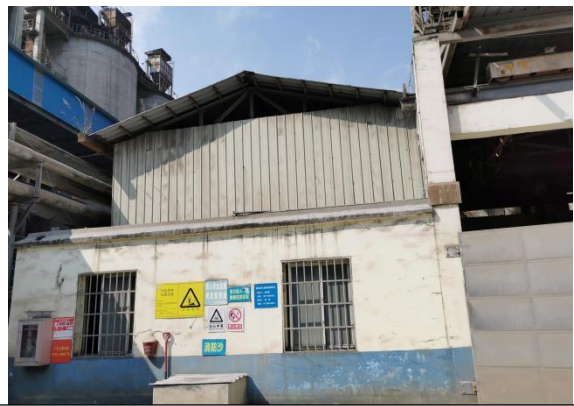
3#线危废处理车间
