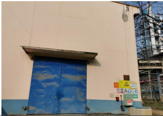
现有危险废物贮存库
