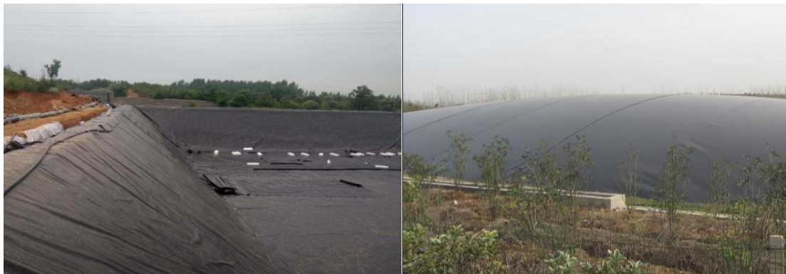
图 2.2-11 黑膜沼气池工程实例
