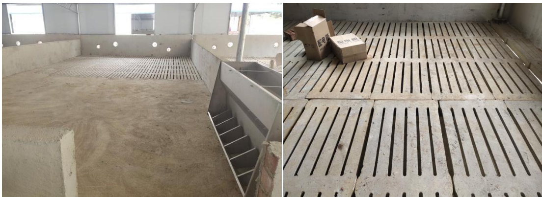
图 2.2-4 猪舍半漏缝地板照片
