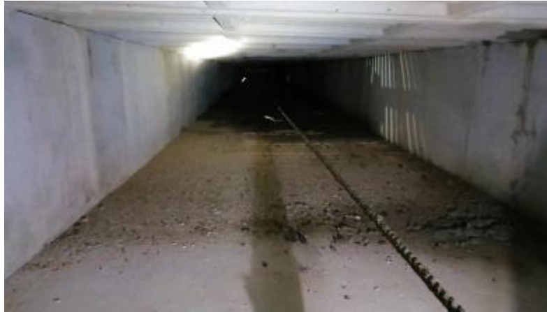
图 2.2-4 猪舍漏缝地板底部粪道工程实例照片
