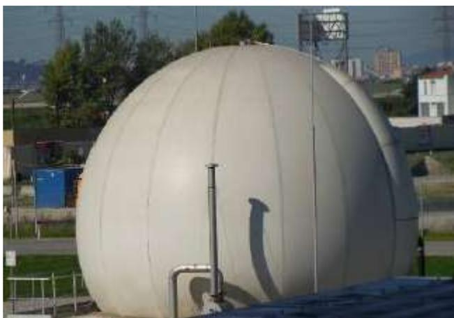
图 2.3.9-3 双膜沼气储气柜外观示意图
